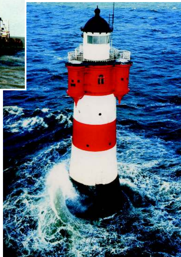
Abb. 3: Nachdem unzählige Wellen, Stürme und die starke Gezeitenströmung dem Turm zugesetzt hatten, sollte er 1964 aufgegeben werden. Mit einer kühnen Rettungsaktion wurden die Fundamente wieder standfest gemacht Foto: Deutsche Stiftung Denkmalschutz
